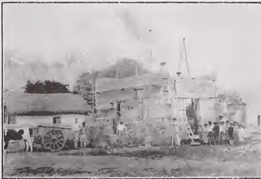
EDIFICIO EN CONSTRUCCIÓN PARA LA ESCUELA
